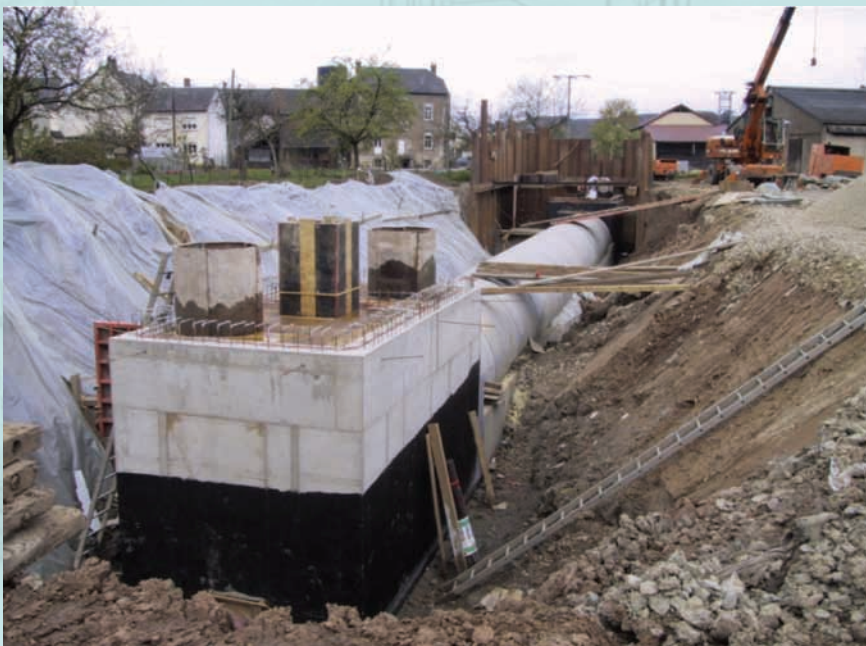
Kanal- und Betonbauarbeiten Los II.
