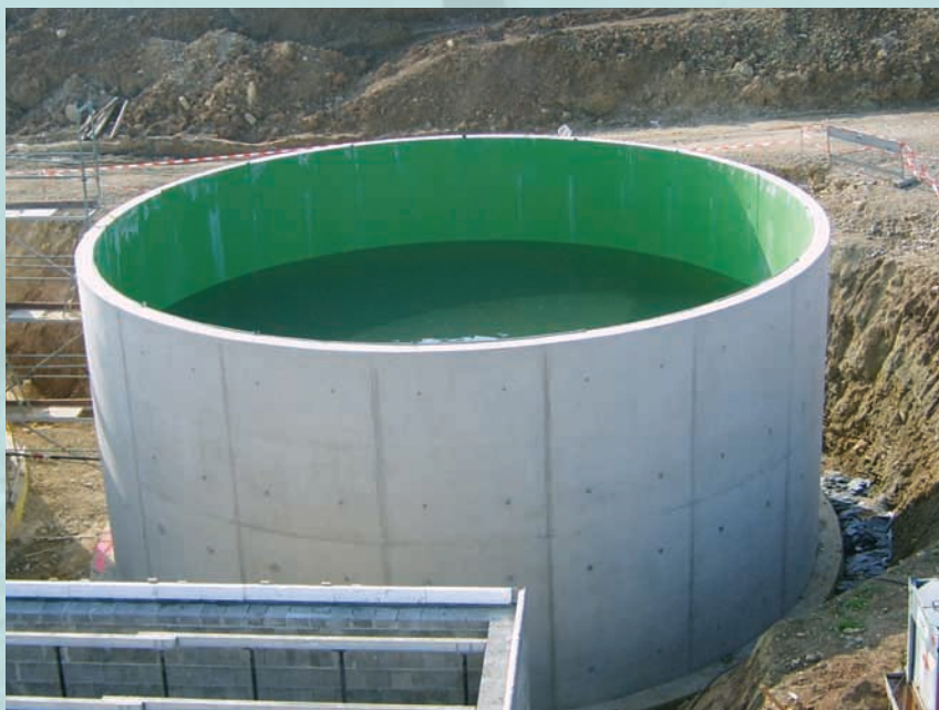
Kläranlage, Schlamm-speicher
