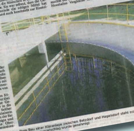
Dem Bau einer Kläranlage wurde genehmigt
