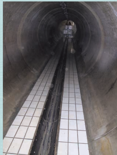
Trockenwettergerinne Kanalstauraum DB 5.02
